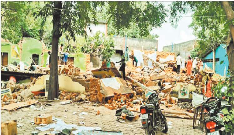
भवन के टूटने के बाद बिखरा मलबा।
