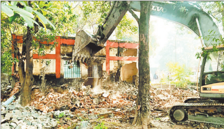
भवन को तोड़ता बुलडोजर।
